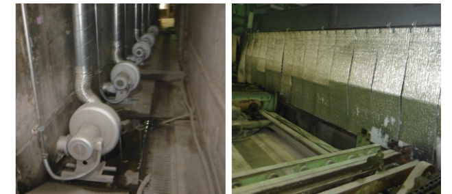
为了稳定养护仓内部温度而新设置的通风扇 (左) 与保温帘 (右)
